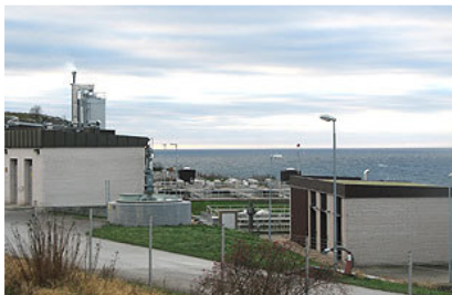
Reningsverket i Visby. Foto: Henrik Wallenius/SR Gotland
